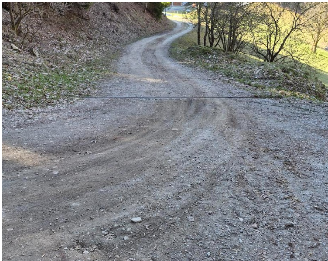
Obstoječa JP 910041 odsek Hudalin - Klavž
